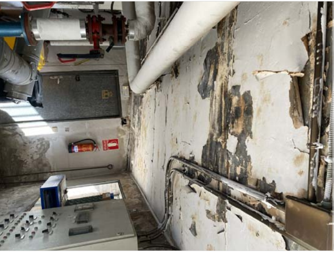
Filtraciones en el cuarto de calderas coincidiendo con una cubierta con muy poco inclinación para ser de teja)
