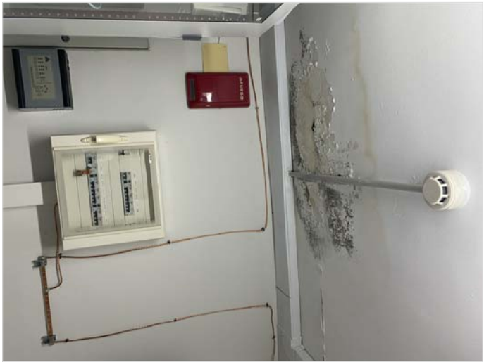
Filtraciones en el cuarto de calderas coincidiendo con el encuentro de dos cubiertas
