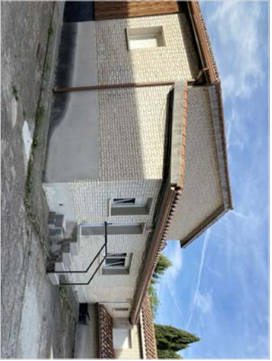
Levanto de tejas en el faldón de la cubierta del office. Levantado de canalón de la base del faldón. Impermeabilización con tela asfáltica. Recolocación de tejas. Recolocación de canalón y bajante
