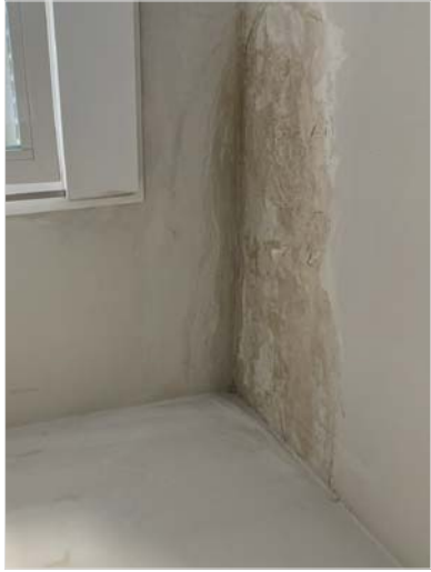
Filtraciones en el cuarto de calderas coincidiendo con una cubierta con muy poco inclinación para ser de teja)
